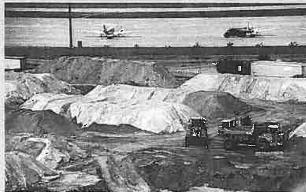
Sanierung Kelsterbach. In Spitzenzeiten waren pro Tag 5000 Tonnen kontaminiertes Erdreich analytisch, logistisch und verwertungstechnisch zu behandeln.
