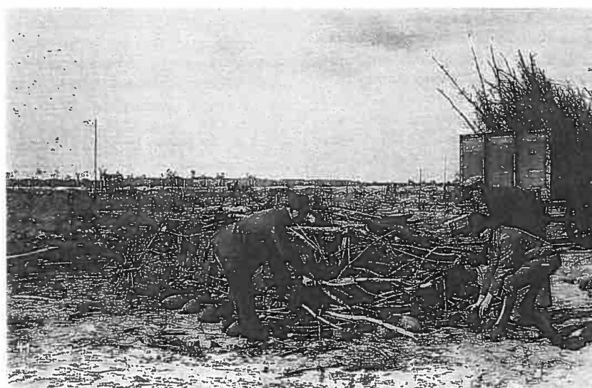
Bild 3: Ausbrennen der Gasgranaten im Reishaufen
