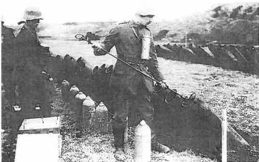
Eine Fortentwicklung des Haber'schen Blasverfahrens war das Verschießen von Gasminen, das allerdings die Engländern erfanden. Hier ist eine Batterie von 18 cm-Minenwerfern zu sehen, die gerade mit Gasminen geladen werden. Gasminenwerfer kamen ab Oktober 1917 von deutscher Seite zu Einsatz. Das etwa 1 m lange Rohr war zur Hälfte eingegraben und auf einer Grundplatte befestigt. Die Treibladung befand sich am Boden der Rohres, die Zündung erfolgte elektrisch. Die Füllung der Gasminen bestand aus Phosgen (teils in Mischung mit Diphosgen) oder Clark I in Mischung mit dem Sprengstoff Hexyl. (Photo Kriegsarchiv München)
